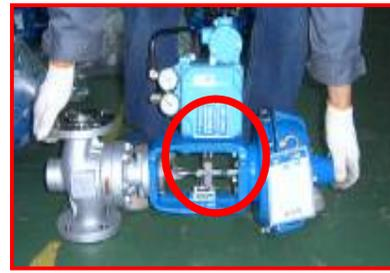
F) VALVE 설치 시 가능한 한 수직으로 설치하며 수직 설치가 불가능한 경우에는 VALVE 에 지지대를 설치한 후 VALVE 를 설치한다. < FIG 3-2, 3-3 참조 >
